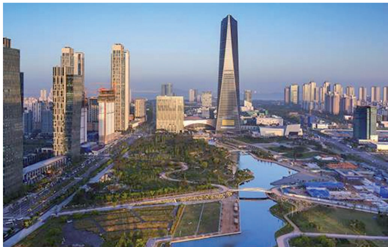
LAVORI IN CORSO. Il progetto di Songdo con il suo parco, in costruzione in Corea del Sud. Sotto, John Rossant
